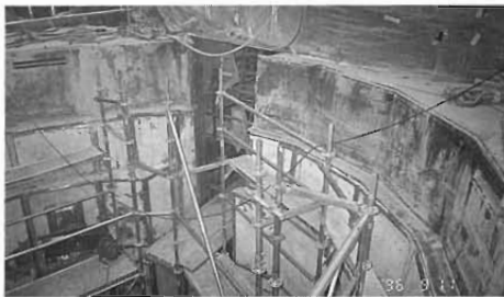
写真 圧力容器撤去後のHDRの炉頂部
